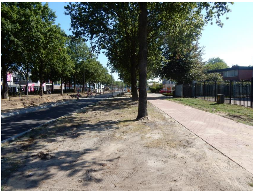
Groot onderhoud Engelseweg Vervangen volledige wegconstructie in combinatie met de aanleg van een regenwaterriool
