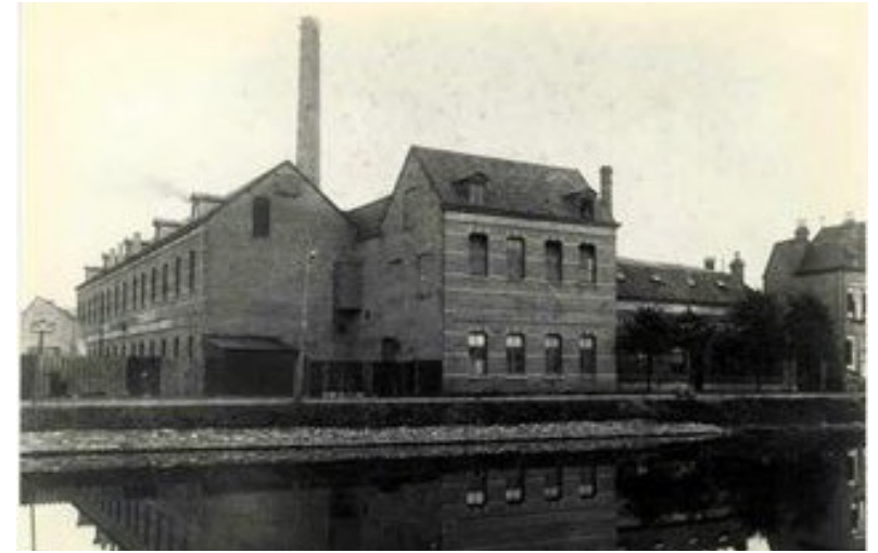
de uitbreiding met de open hoek aan de kanaalzijde
