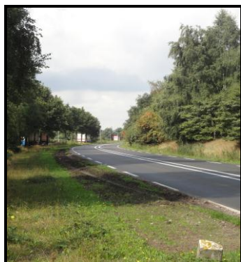
Groot onderhoud Rochadeweg – POW 2013 De volledige asfaltconstructie is vervangen.
