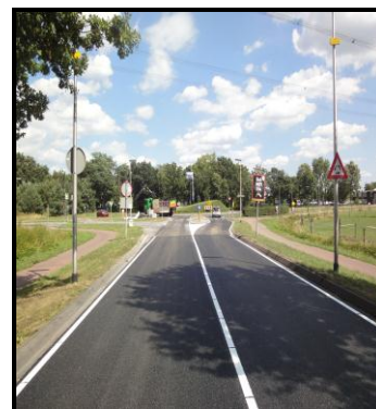
Groot onderhoud Geldropseweg – POW 2013 De geluidsreducerende deklaag is vervangen
