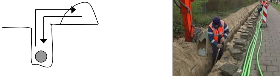
Figuur 3.2: Werkzaamheden kabels en leidingen
