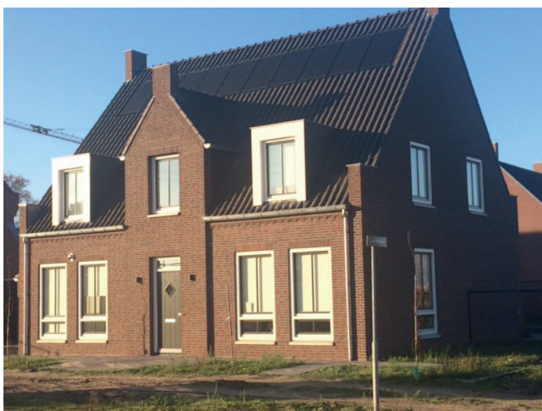
Zonnepanelen als indak oplossing op een woning in Brandevoort.
