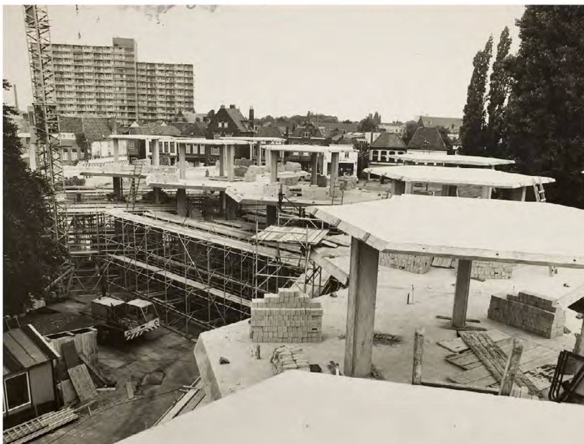
Bouw van de paalwoningen in het centrum van Helmond. Boven de huizen aan de Markt steekt de Ameideflat uit – 1978 [Jozef van den Broek/RHCE]
