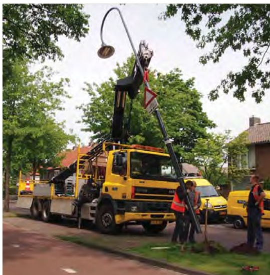
Afbeelding 1: Het vervangen van verlichtingsobject in de Azalealeaan als onderdeel van langcyclisch onderhoud
