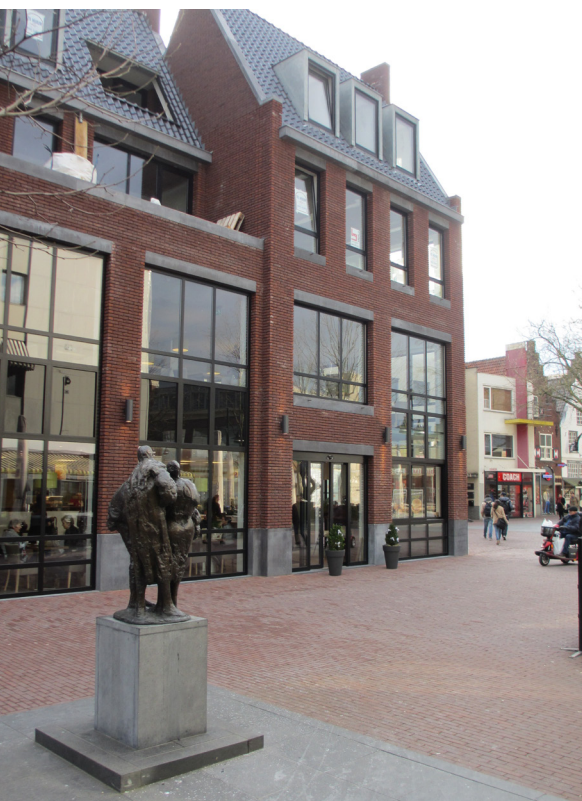
Nieuwbouw hoek Ameidestraat en Markt
