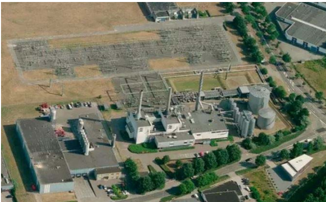
Foto: huidige warmtecentrale van Ennatuurlijk in Helmond
