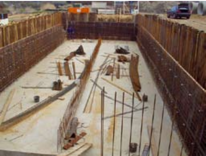
▣ Aanleg bergbezinkbassin Kanaaldijk ZW.
