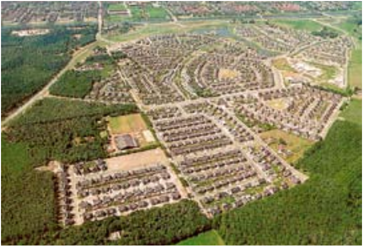
▶ Luchtfoto Dierdonk in aanbouw.
