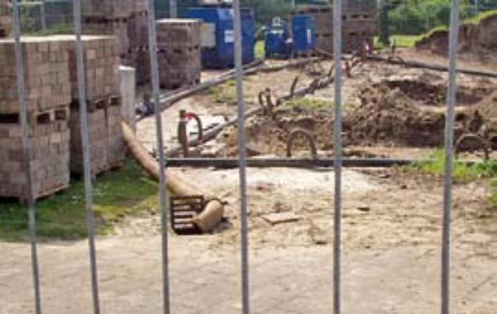
▣ Bronnering bij een bouwproject tegen instroming van grondwater in de bouwput.
