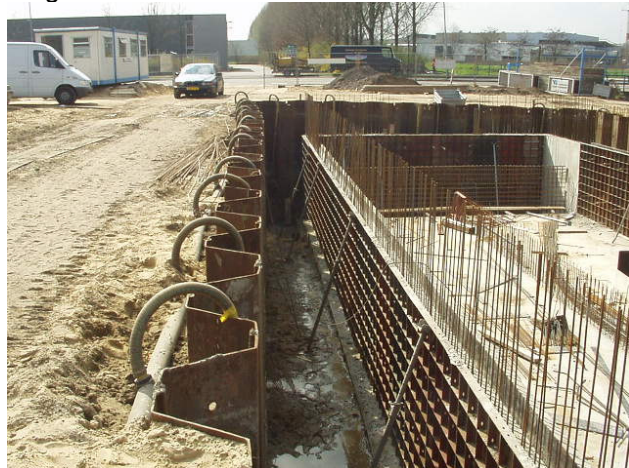
figuur D Aanleg bergbezinkbassin industrieterrein De Weijer
