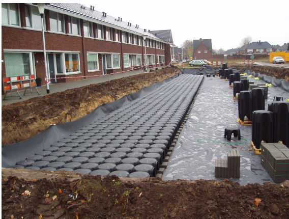
figuur U Aanleg van een ondergrondse infiltratievoorziening in de Spitsmuisstraat
